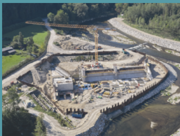
Aktueller Baufortschritt im September 2026.
