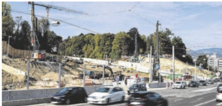
Die Arbeiten im Bereich Waldeggstraße laufen auf Hochtouren. Foto: Volker Weihbold
