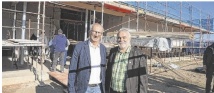
Die beiden Bürgermeister Peter Rachinger (Neufelden) und Klaus Gattringer (Altenfelden, v.l.) sind zufrieden mit dem Baufortschritt.
