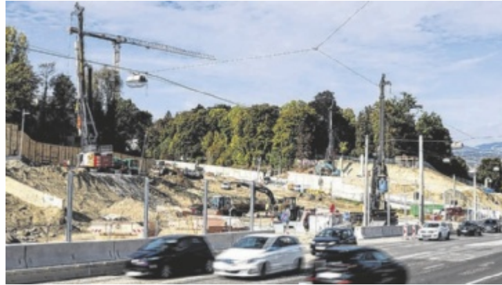
Die Arbeiten im Bereich Waldeggstraße laufen auf Hochtouren. Foto: Volker Weibhold
