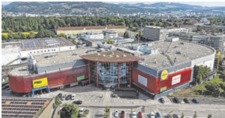
Die IT:U soll ins ehemalige Kika-Gebäude ziehen.
