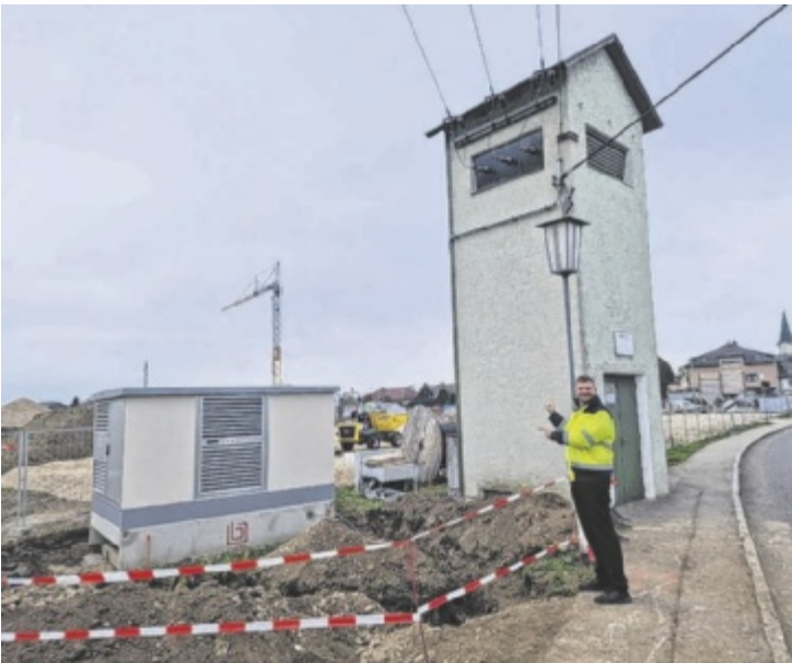
Bürgermeister Thomas Altöf begutachtet die neue Trafostation in Pucking, die das Stromnetz stärkt und einen breiteren Gehsteig ermöglicht. Foto: Marktgemeinde Pucking
