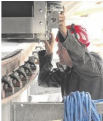
Bau Salzbergbahn Foto: Servus TV/Aglassinger
