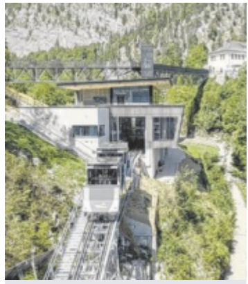
Bauarbeiten Eine TV-Doku zeigt den spektakulären Bau der neuen Hallstätter Salzbergbahn. Seite 5 / Foto: Servus TV/Aglassinger
