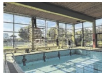
Nach Sanierungsmaßnahmen öffnet die Freistädter Badeanlage wieder ihre Türen. Foto: Stadtgemeinde Freistadt
