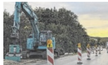
Für die Baustelle ist eine halbseitige Sperrung notwendig
