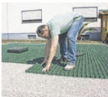
Rasengitter können problemlos in Eigenregie verlegt werden. Foto: epr/Gutta
