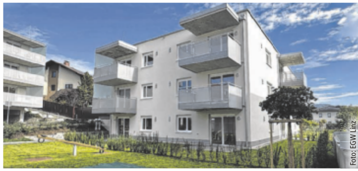
15 neue Mietwohnungen bieten modernen Wohnkomfort in zentraler Lage in Walding.
