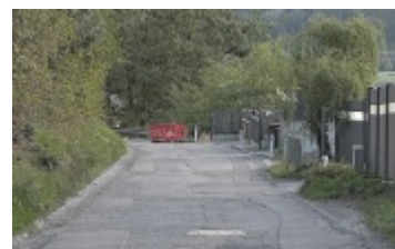
Die Holzwindener Straße wurde einspurig freigegeben. Foto: Sebastian Scherb
