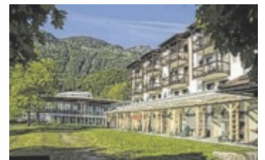
Neubau und Altbau Foto: Wolfgang Stadler
