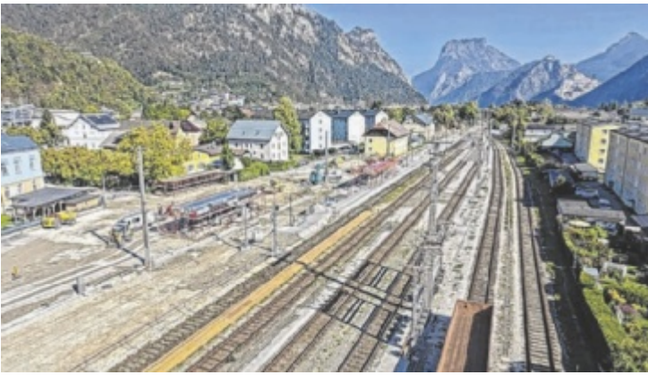
In Ebensee wurde das Bahnhofsgebäude abgerissen und gegen einen modernen Bahnsteig erneuert Foto: Hörmandinger
