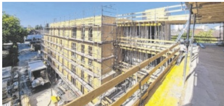
Der Holzbau steht: Rund 380.000 Kilogramm Holz stecken in den beiden Häusern in der Grünbachstraße.
