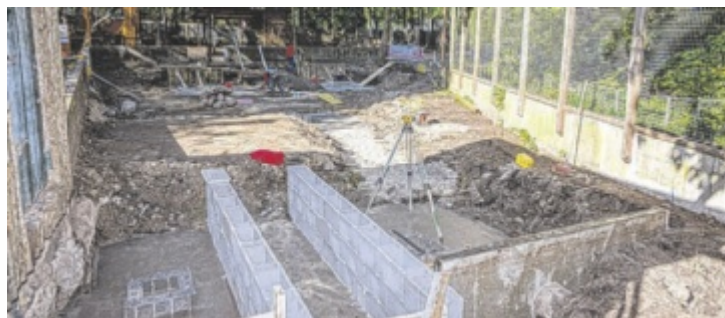
Gehege werden auch umgebaut.
