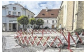
Zwei Rohrbüchse in Zwettl an der Rodl bereits behoben. Foto: Privat
