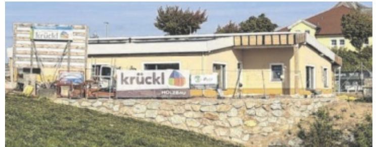
Der Bau der neuen Krabbelstube in Allerheiligen schreitet voran. Fertigstellung ist für März oder April 2027 geplant.
