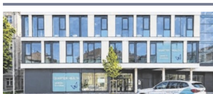
Das neue Quartier.health in der Prinz-Eugen-Straße
