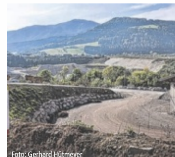
Hinten rechts über der Landesstraße ist die neue Schottergrube geplant.
