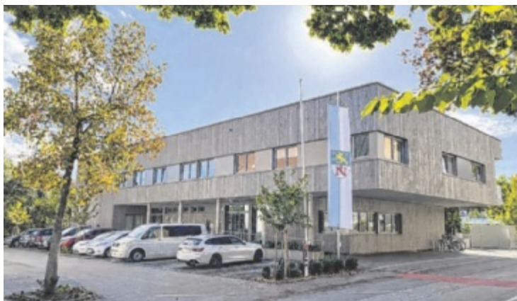
Nach dem neuen Amtsgebäude stehen weitere Projekte an.
