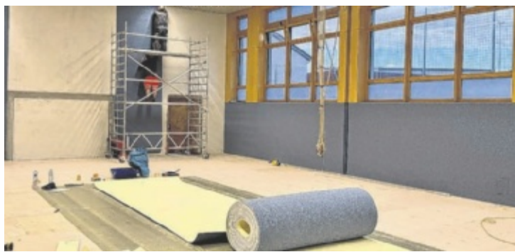
Generalsanierung des Turnsaals der Volksschule.
