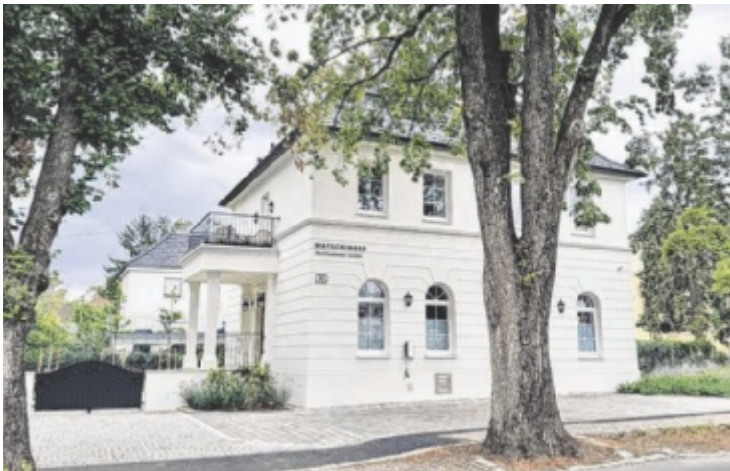
Das sanierte Eckhaus an der P.-Rosegger-Straße
