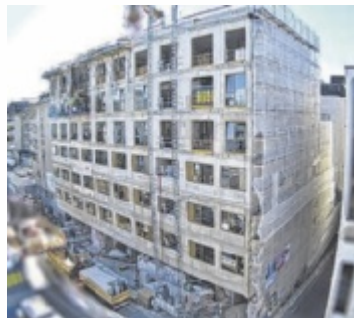
Die Dachgleiche beim neuen Bauteil M ist erreicht. Foto: Ordensklinikum Linz
