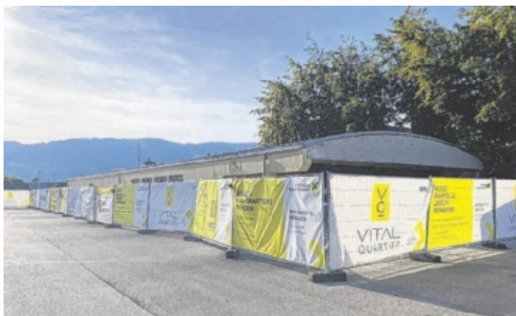
Der Spatenstich für das Vital-Quartier ist für Donnerstag, 15. Oktober, angesetzt. Das alte Billa-Gebäude wird zuvor abgerissen.
