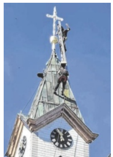
Bei der Turmkreuzsteckung Foto: Degelsegger
