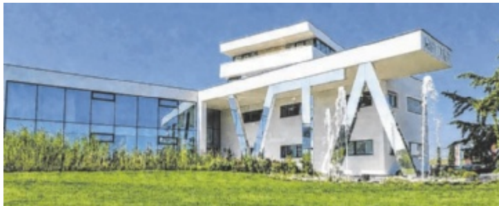
iDie Zentrale der VTA Gruppe von Ulrich Kubinger in Rottenbach.
