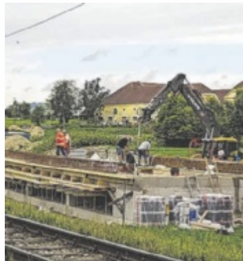
Bauarbeiten an der neuen Aschachbrücke
