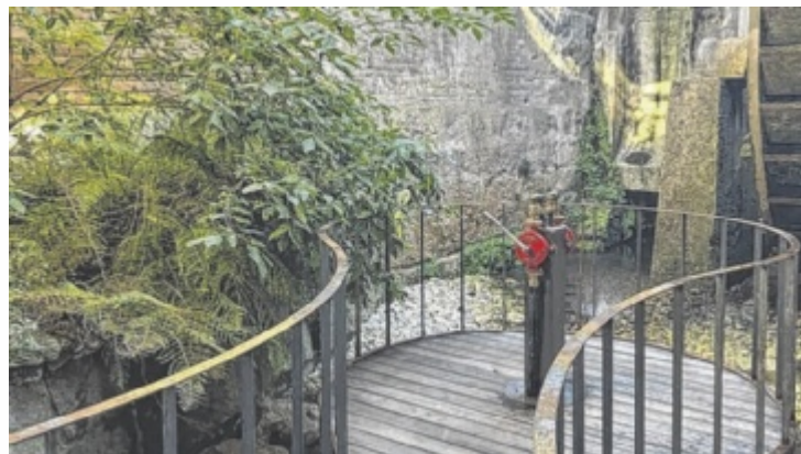
Wasserstation in der Furthmühle
