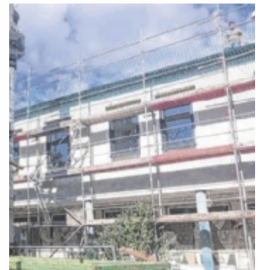
Auch an der Fassade wird gearbeitet.
