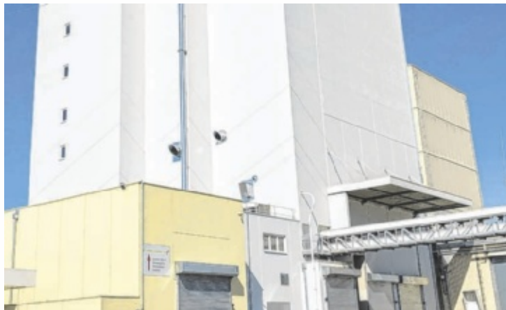
Der neue Multifunktionssilo von Fixkraft bietet eine Kapazität von 12.000 Kubikmetern.
