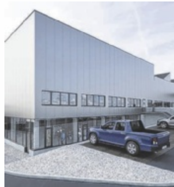
Hallenzubau beim Schinko in Matzelsdorf
