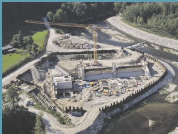
Aktueller Baufortschritt im September 2026.
