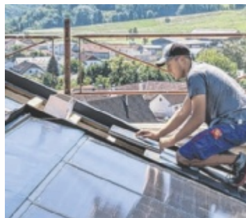
Arbeiten, wo andere hinaufblicken – Dachdecker und Spengler sind Fachkräfte mit Zukunft.
