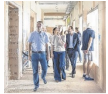
Bei einem Rundgang durch die Baustelle der Volksschule konnten sich die Ehrengäste ein Bild vom Baufortschritt machen.
