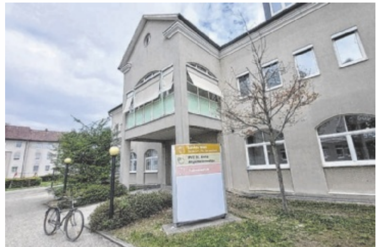
Blick auf das Primärversorgungszentrum St. Anna
