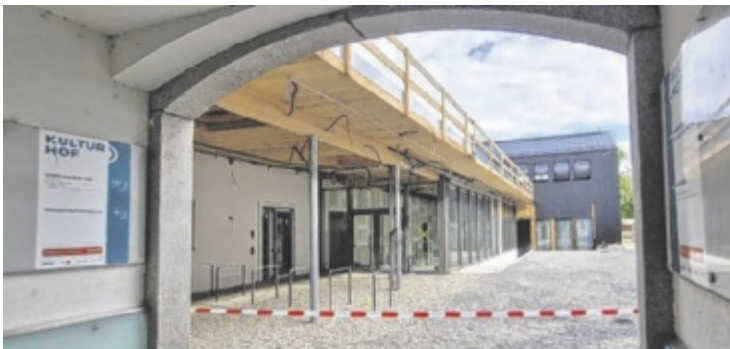
Der Kultur Hof nimmt Formen an: Das verglaste Foyer und der dahinterliegende neue Veranstaltungssaal stehen. Foto: Tips/Heindl
