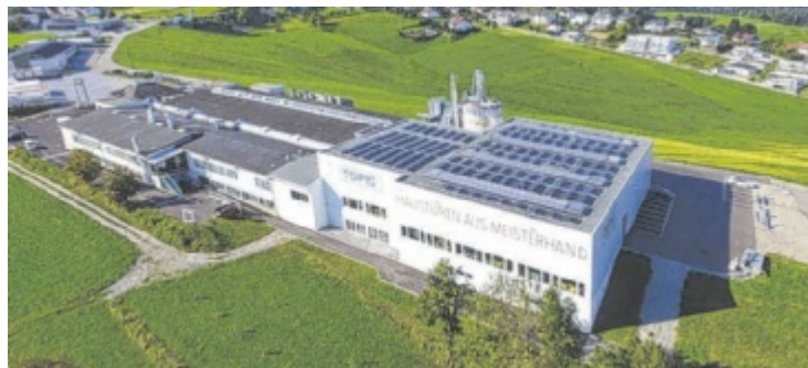
Das TOPIC-Betriebsgebäude in Sarleinsbach
