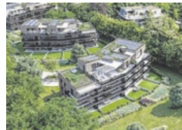
Im Sompark entsteht das Wohnprojekt „Das Prime“. Foto: Real-Treuhand Immobilien
