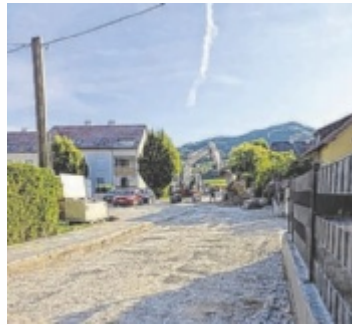
Die Burgstraße befindet sich in der zweiten Bauphase. Foto: Gemeinde Micheldorf
