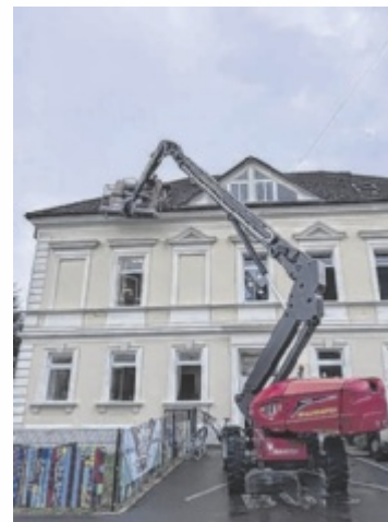
Der Hort wurde bereits umfassend saniert.
