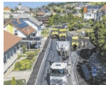
Die Generalsanierung ist abgeschlossen.
