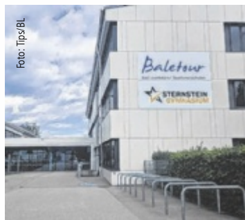
Das neue Logo wurde schon angebracht.
