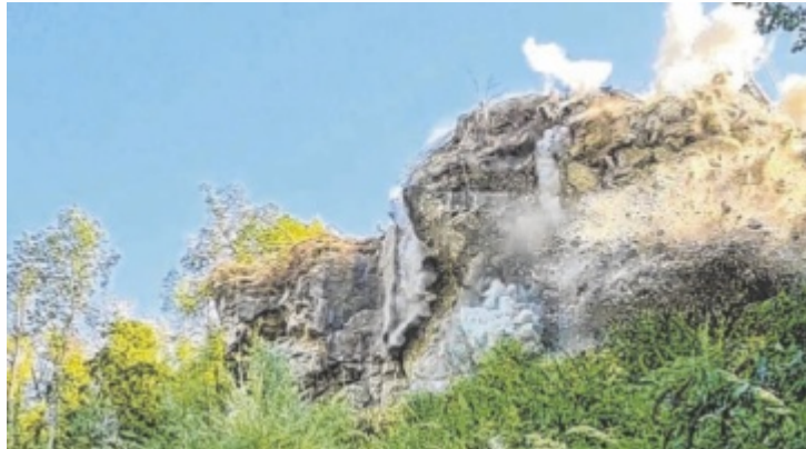
Die Probesprengung am 11. August bei der Konglomeratwand in Unterhimmel verlief erfolgreich.
