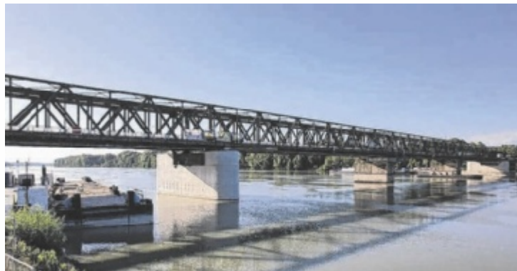
2028 soll das Tragwerk der Donaubrücke getauscht werden.
