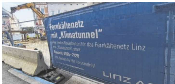
Im Bereich Rainerstraße und Volksgartenstraße wird gebaut.
