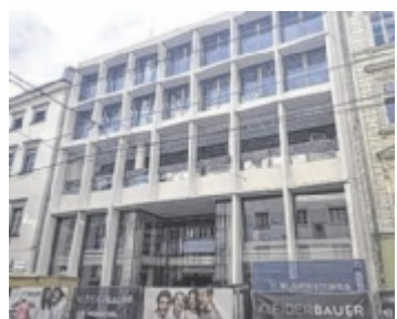
Im Endspurt sind die Arbeiten bei Kleider Bauer, eröffnet wird Ende September. Fotos (3): Tips/ks
