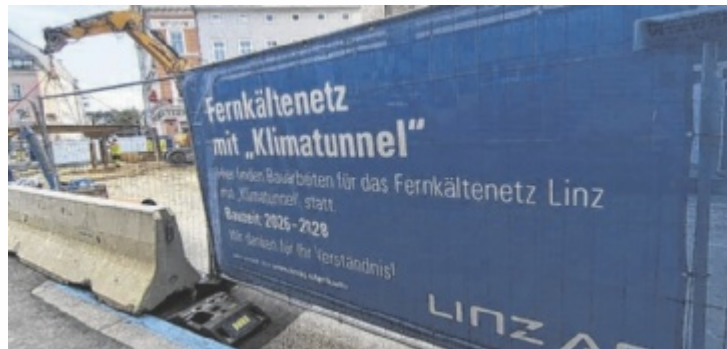
Im Bereich Rainerstraße und Volksgartenstraße wird gebaut.
