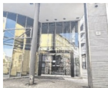
Der ehemalige GEOX-Store an der Landstraße 62 – ab geplant Frühjahr 2027 wird Biogena hier zu finden sein.
