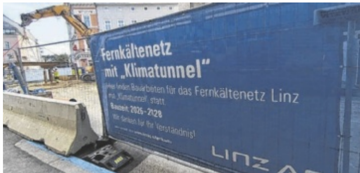
Im Bereich Rainerstraße und Volksgartenstraße wird gebaut.
