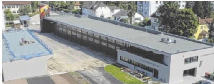
Das neue Feuerwehrgebäude - hier bei Bauarbeiten im Juli 2026 Foto: Bildarchiv FF Enns
