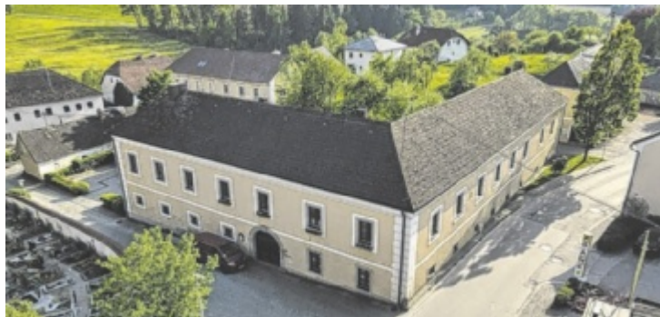
Der Baustart beim Pfarrhof soll noch heuer erfolgen.
