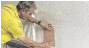
Der Löschpapier-Test Foto: VEINAL
