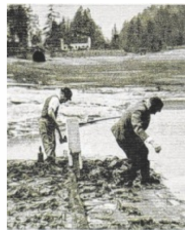
Arbeiter 1959 am Nussensee
