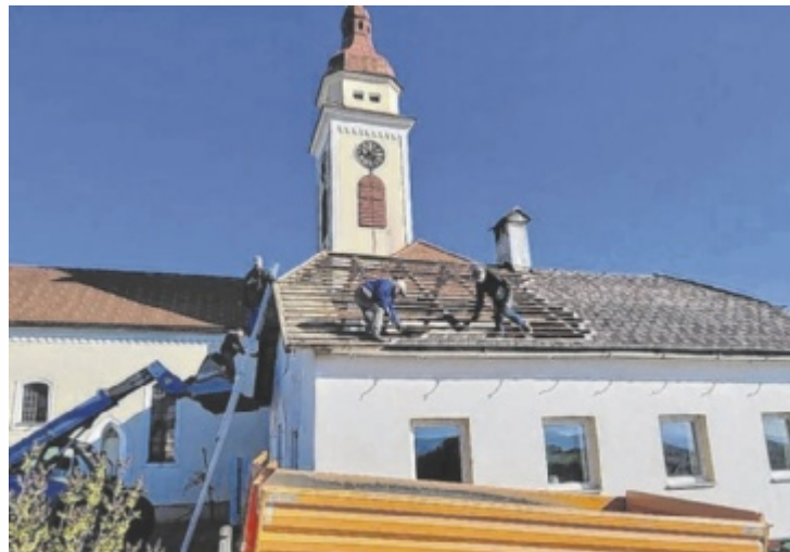
Da wurde das Dach abgetragen.
