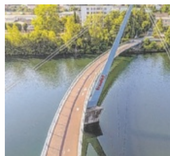
Der Trodatsteg wird saniert.
