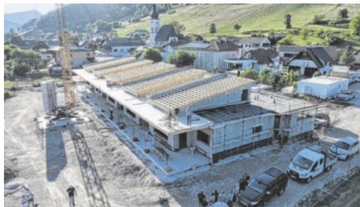
Der Bau des neuen Gaflenzer Kindergartens schreitet voran. Foto: Marktgemeinde Gaflenz
