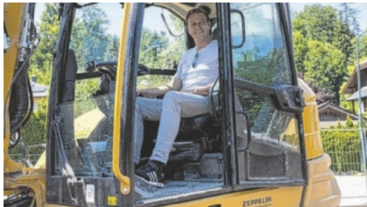
Bei einem Entsiegelungsprojekt in Bad Ischl stieg LR Stefan Kaineder kürzlich selbst in den Bagger und brach den Beton auf.
